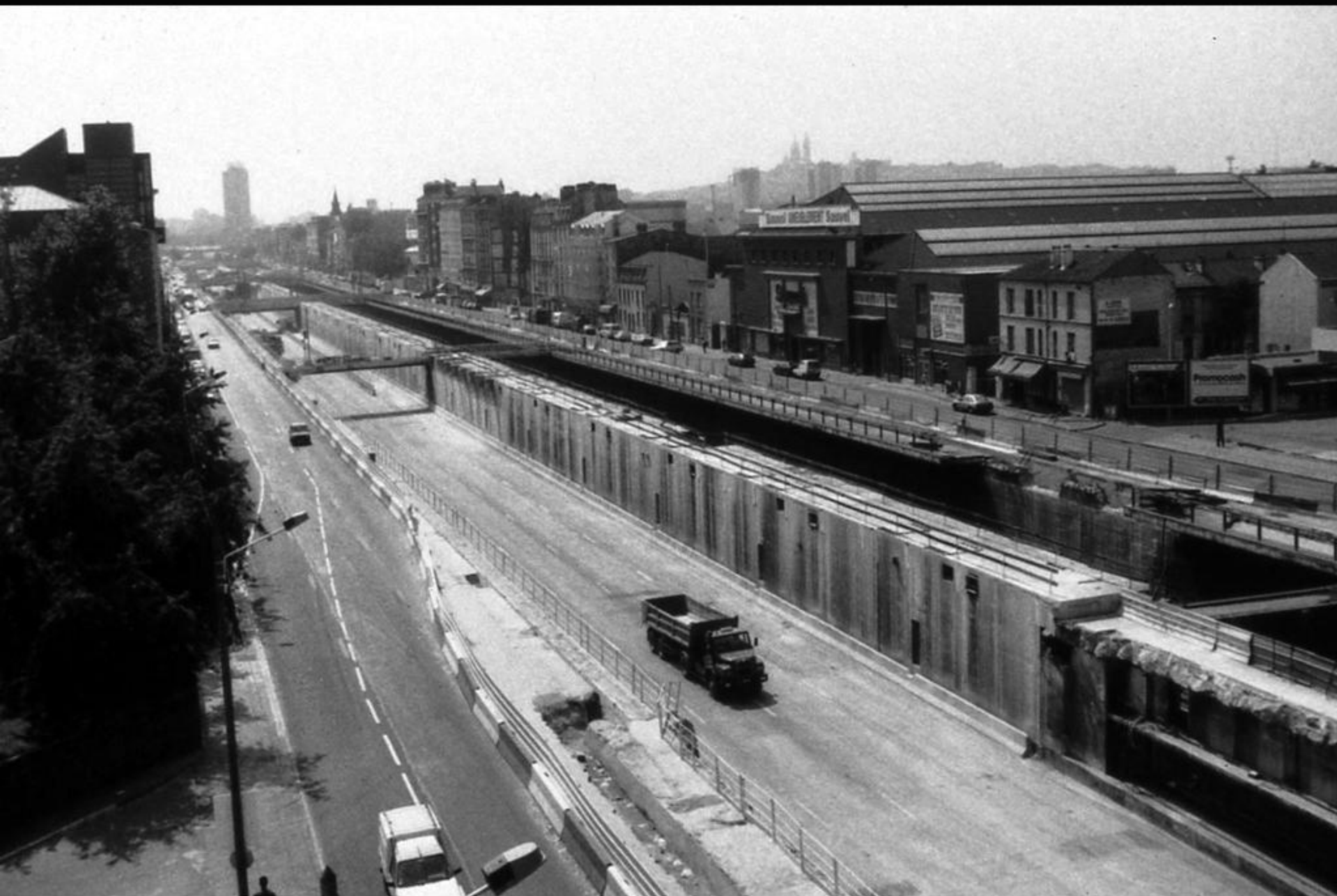
Travaux de couverture de la tranchée de l'autoroute A1
