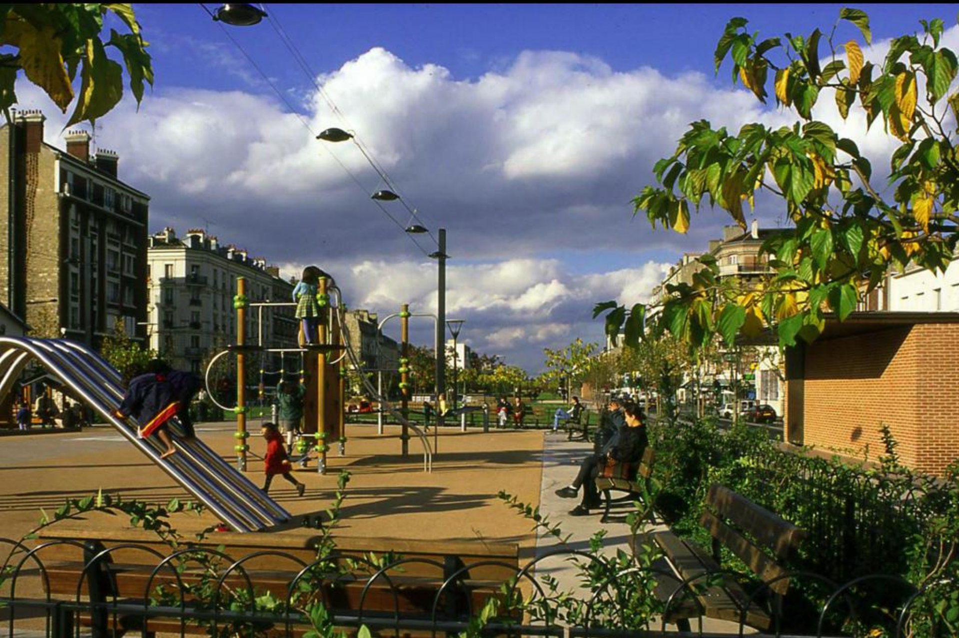
Couverture de l'autoroute A1: Saint-Denis. Atelier Corajoud
