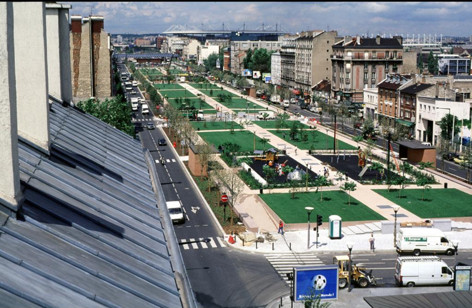
Couverture de l'autoroute A1: Saint-Denis. Atelier Corajoud
