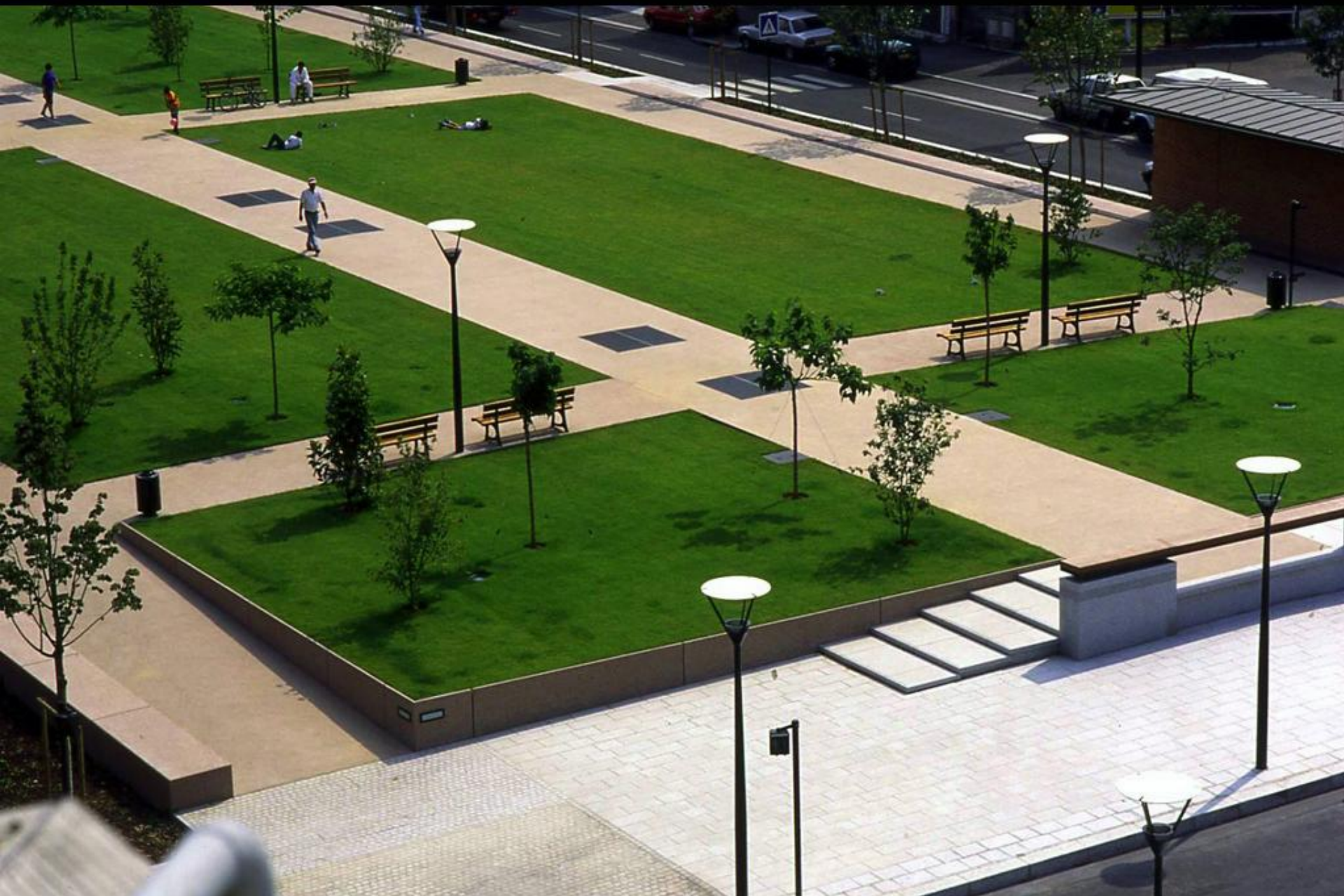
Couverture de l'autoroute A1: Saint-Denis. Atelier Corajoud
