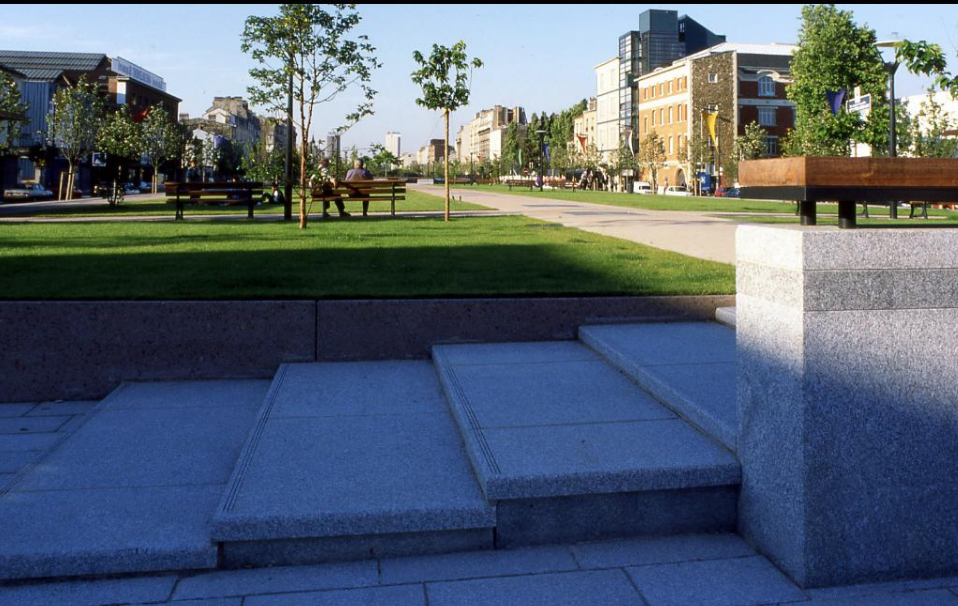
Couverture de l'autoroute A1: Saint-Denis. Atelier Corajoud
