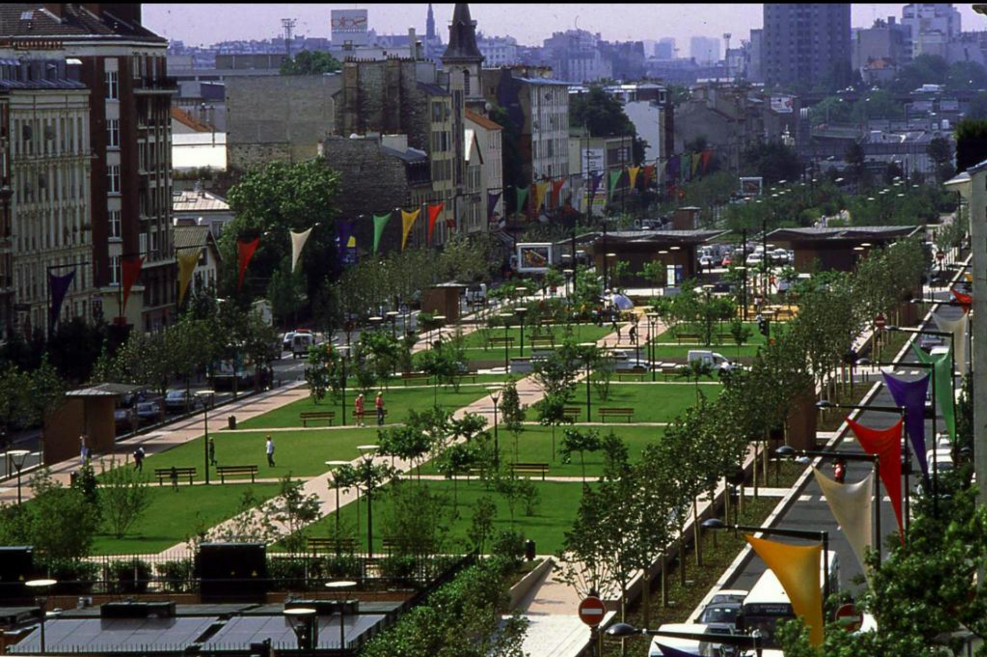
Couverture de l'autoroute A1: Saint-Denis. Atelier Corajoud
