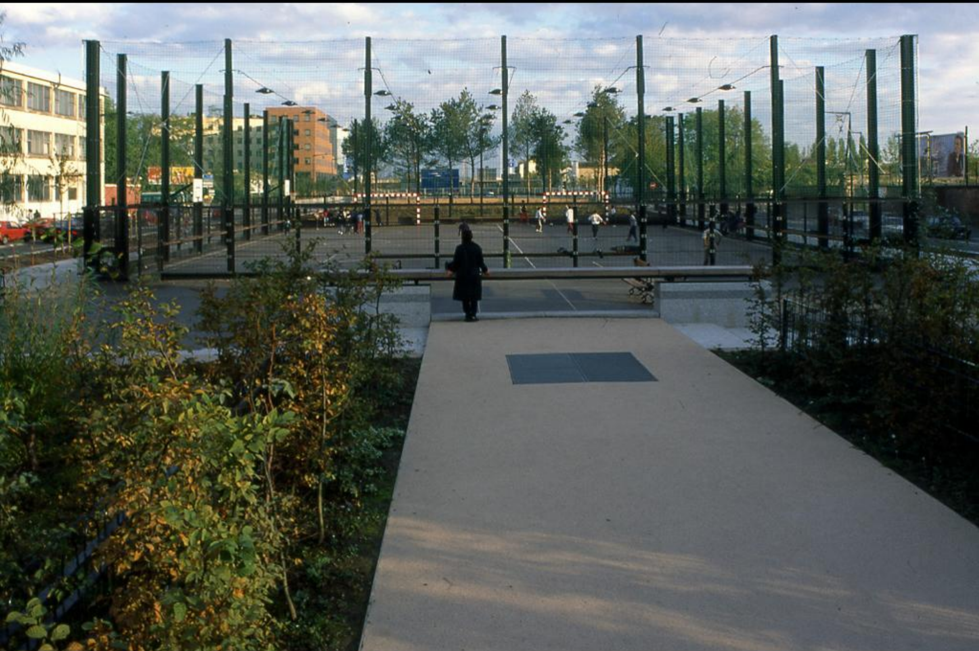
Couverture de l'autoroute A1: Saint-Denis. Atelier Corajoud
