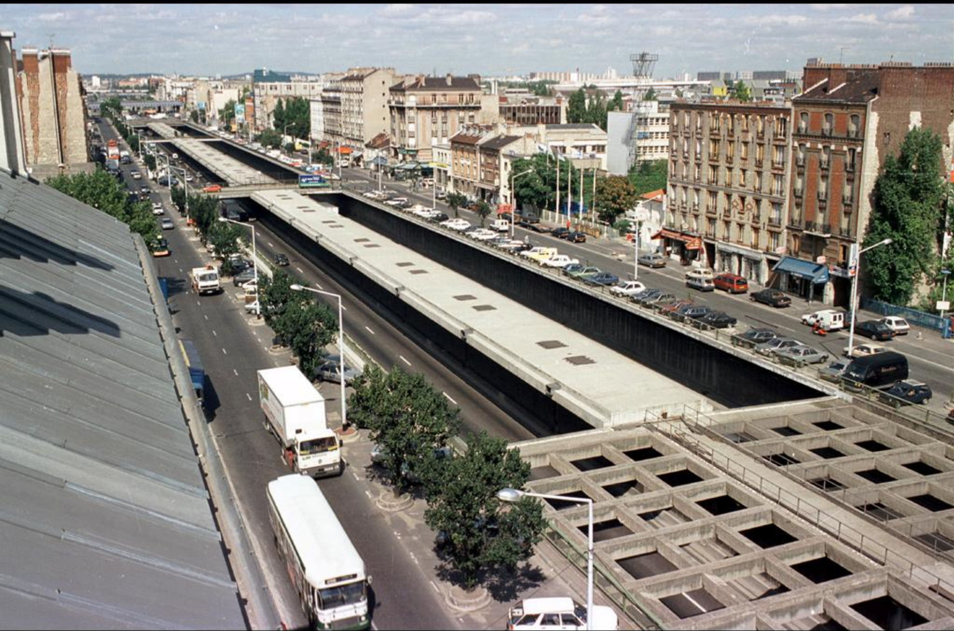
Couverture de l'autoroute A1: Saint-Denis. Atelier Corajoud
