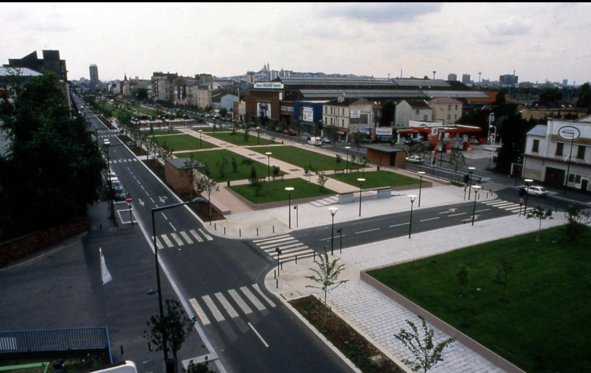
Couverture de l'autoroute A1: Saint-Denis. Atelier Corajoud
