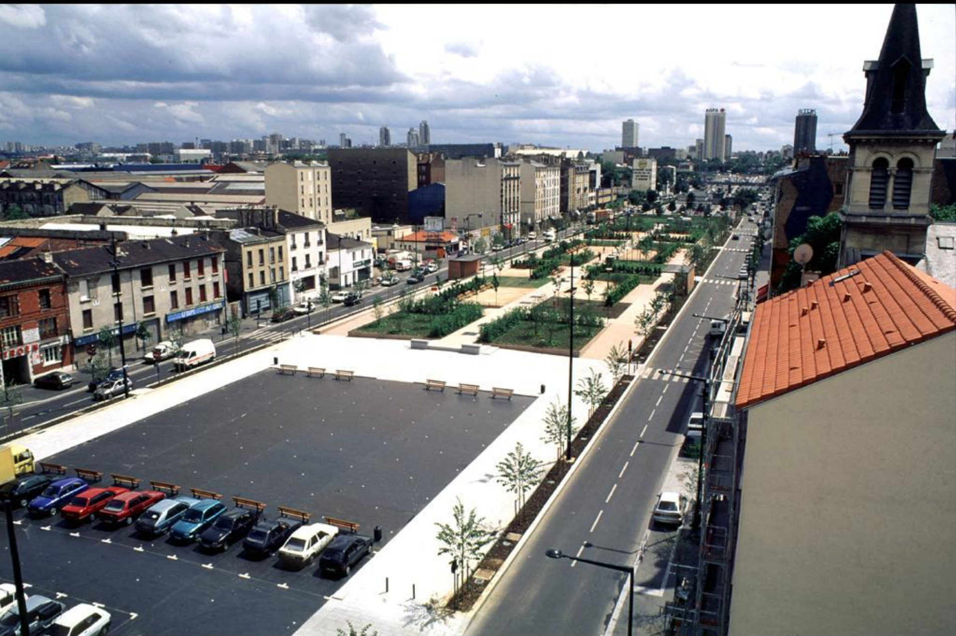
Couverture de l'autoroute A1: Saint-Denis. Atelier Corajoud
