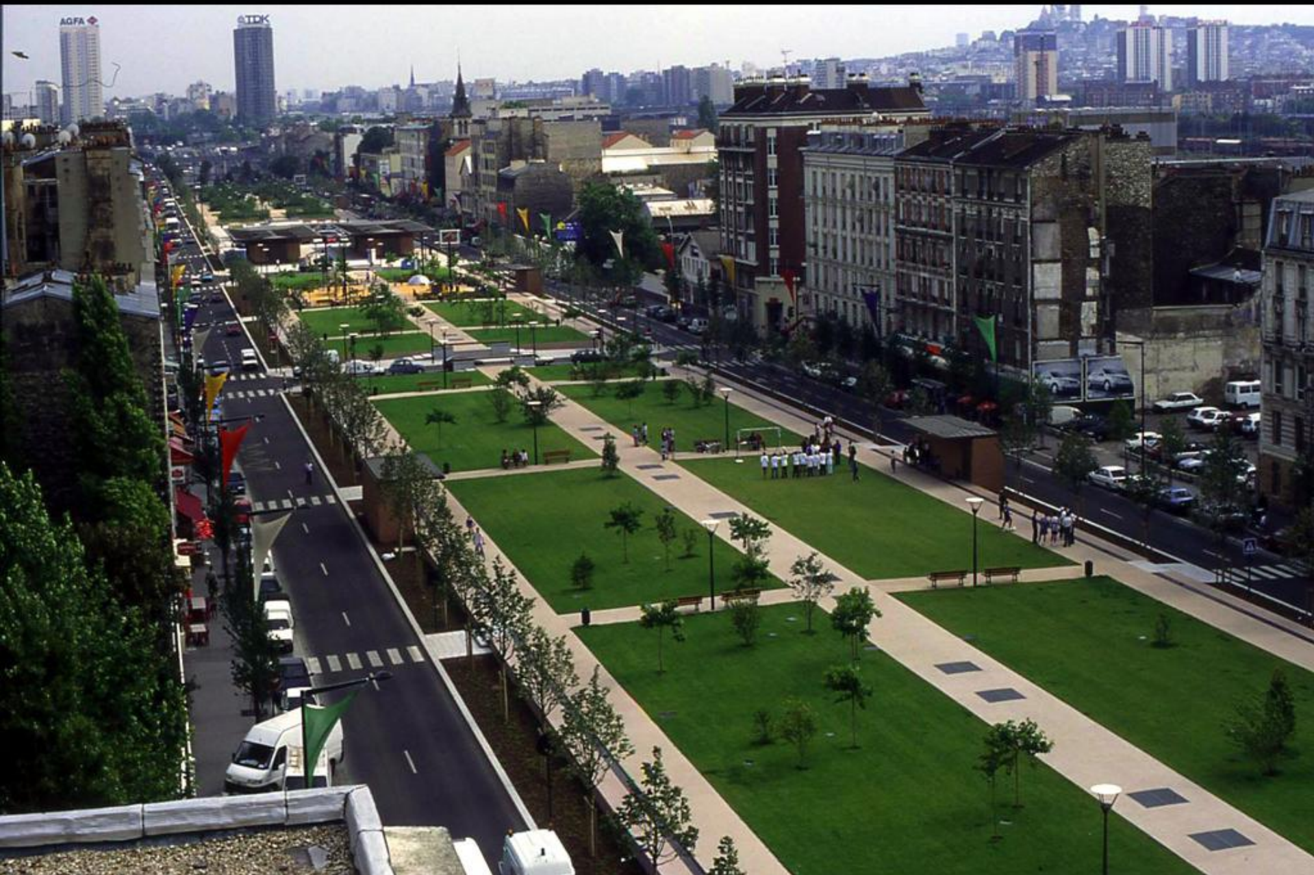
Couverture de l'autoroute A1: Saint-Denis. Atelier Corajoud
