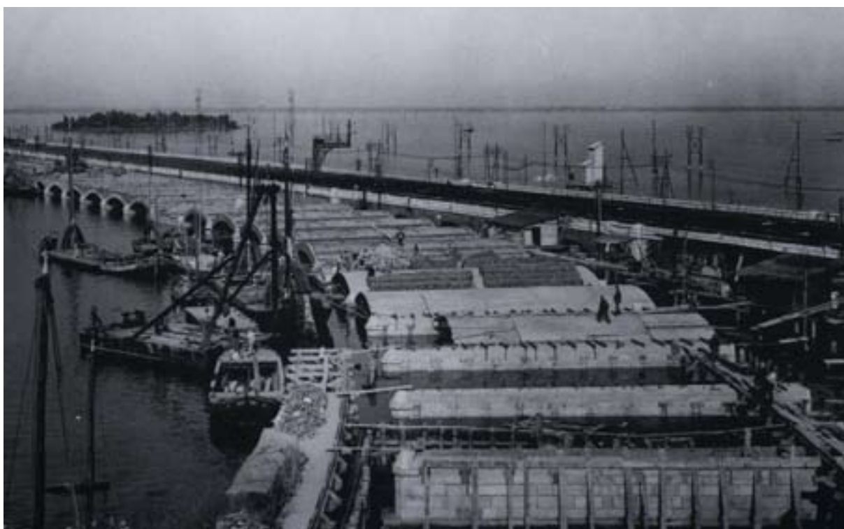
The car bridge followed in 1933 Il ponte automobilistico segue nel 1933
