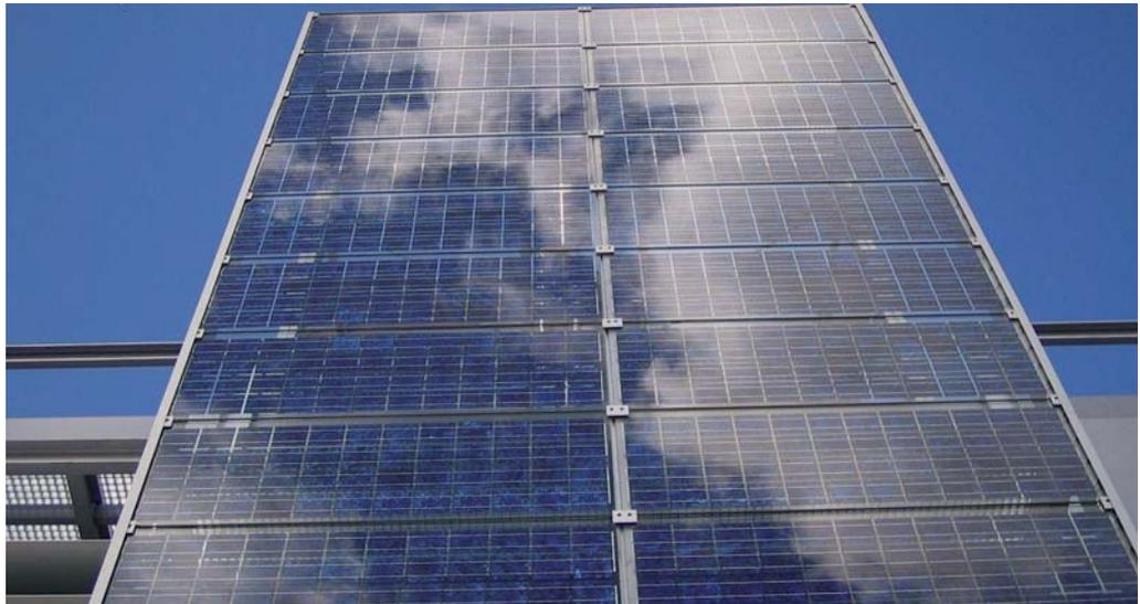
La instalación dispone de paneles fotovoltaicos que actúan como generadores naturales de energía eléctrica de cristal-cristal de gran rendimiento colocados verticalmente como un muro cortina de vidrio azulado en la fachada sur.
