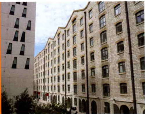
Les docks transformés en bureaux.
