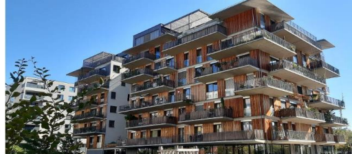
Nordbahnhofviertel © Bojan Šc
